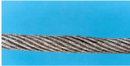
Augmentation locale du diamètre du câble due à l'extrusion de l'âme
